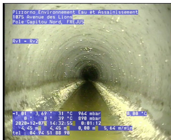
Photo: 1_1_2_A.jpg 4,45m, Dépôts adhérents, graisse de 5 à 7 h. réduction de la section transversale: 10 %, Début
