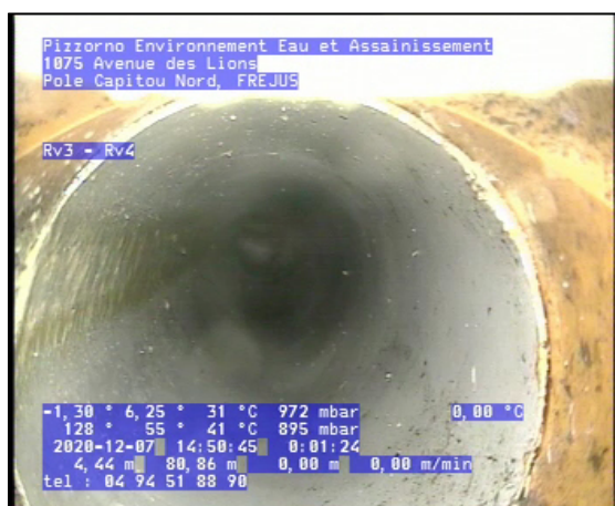
Photo: 3.3_17_B.jpg 4,06m, Culotte, raccordement ouvert à 9 h., hauteur: 125 mm, (largeur: 125 mm)
