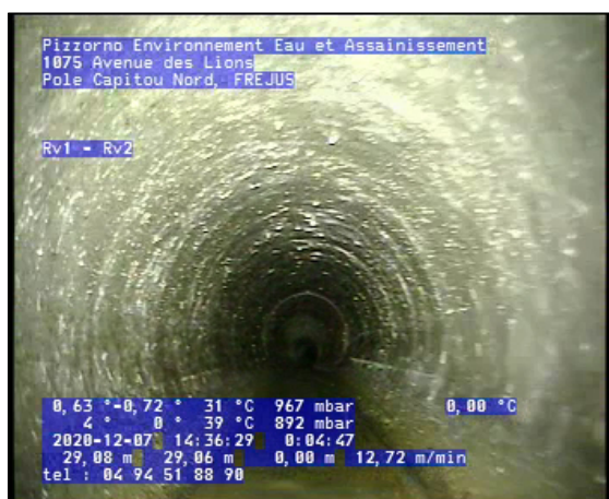
Photo: 1_1_7_A.jpg 29,06m, Dépôts adhérents, graisse de 5 à 7 h. réduction de la section transversale: 5 %, Fin
