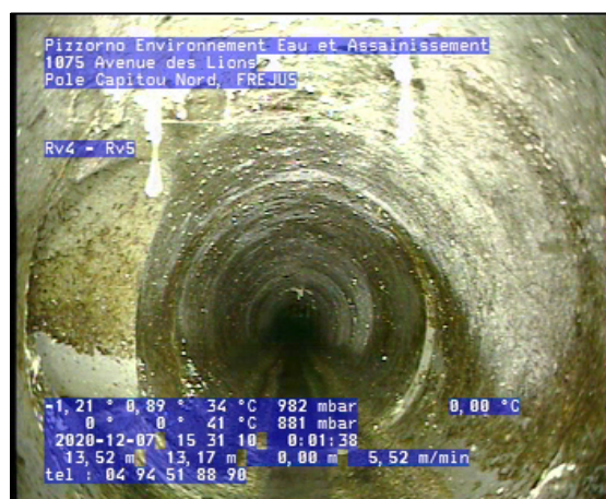
Photo: 4_4_23_A.jpg 13,51m, Culotte, raccordement ouvert à 9 h., hauteur: 125 mm, (largeur: 125 mm)
