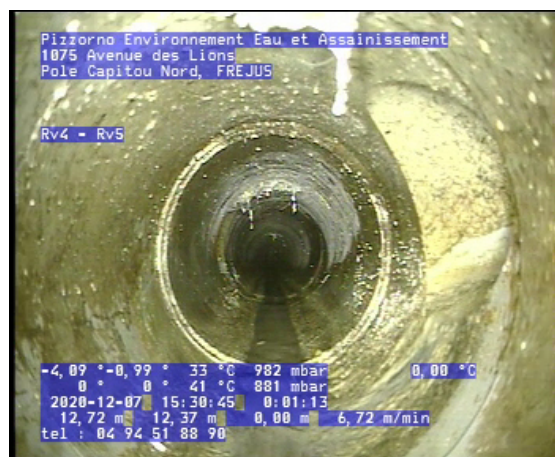
Photo: 4_4_22_A.jpg 12,72m, Culotte, raccordement ouvert à 3 h., hauteur: 125 mm, (largeur: 125 mm)
