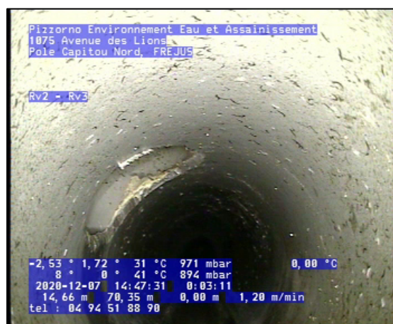
Photo: 2_2_13_A.jpg 14,66m, Culotte, raccordement ouvert à 10 h., hauteur: 125 mm, (largeur: 125 mm)
