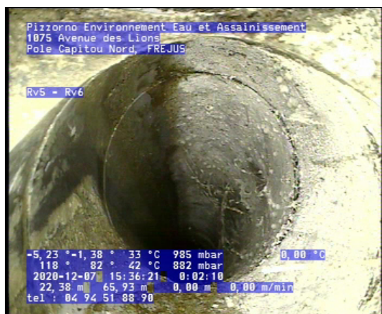
Photo: 5_5_28_B.jpg 22,03m, Culotte, raccordement ouvert à 9 h., hauteur: 125 mm, (largeur: 125 mm)
