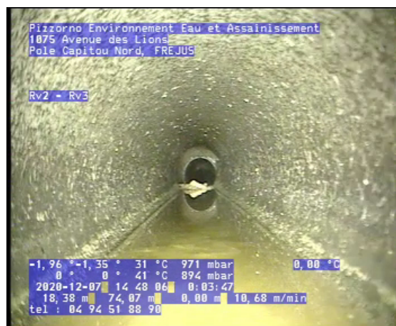
Photo: 2_2_14_A.jpg 18,37m, Niveau d'eau, trouble, niveau exprimé en pourcentage du diamètre: 10 %
