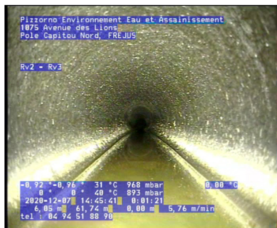
Photo: 2_2_11_A.jpg 6,03m, Niveau d'eau, trouble, niveau exprimé en pourcentage du diamètre: 10 %
