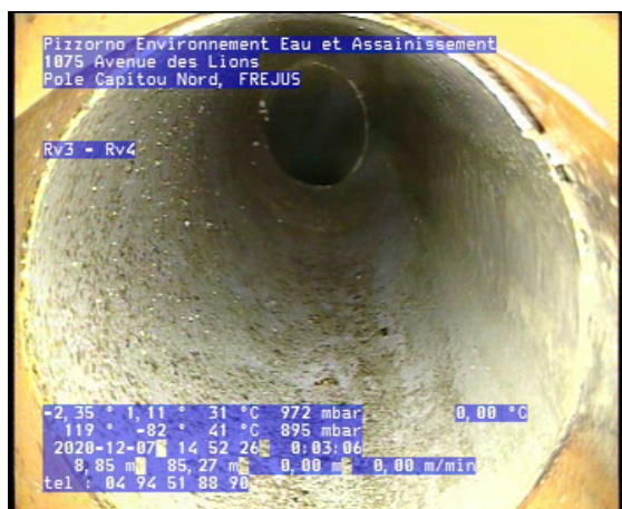
Photo: 3_3_18_B.jpg 8,38m, Culotte, raccordement ouvert à 3 h., hauteur: 125 mm, (largeur: 125 mm)
