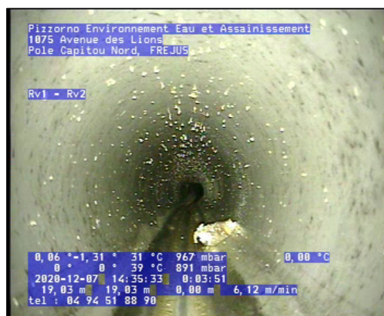
Photo: 1_1_4_A.jpg 19m, Dépôts adhérents, graisse de 5 à 7 h. réduction de la section transversale: 10 %, Fin
