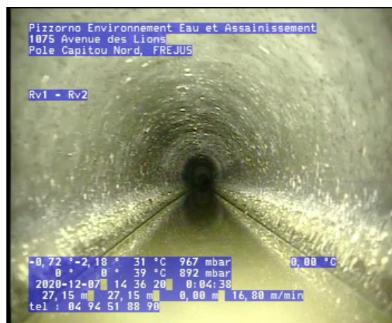
Photo: 1_1_6_A.jpg 27,15m, Niveau d'eau, trouble, niveau exprimé en pourcentage du diamètre: 10 %
