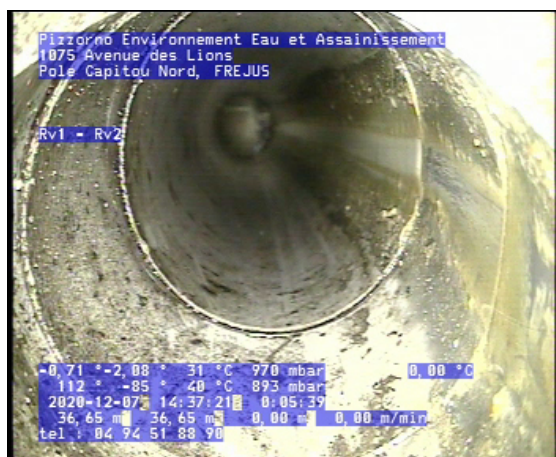
Photo: 1_1_8_B.jpg 36,35m, Culotte, raccordement ouvert à 4 h., hauteur: 125 mm, (largeur: 125 mm)
