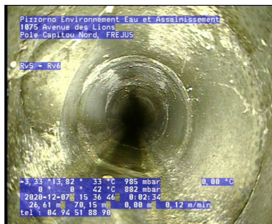
Photo: 5_5_29_A.jpg 26,61m, Culotte, raccordement ouvert à 10 h., hauteur: 125 mm, (largeur: 125 mm)
