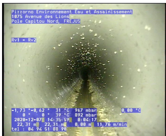
Photo: 1_1_5_A.jpg 22,28m, Dépôts adhérents, graisse de 5 à 7 h. réduction de la section transversale: 5 %, Début
