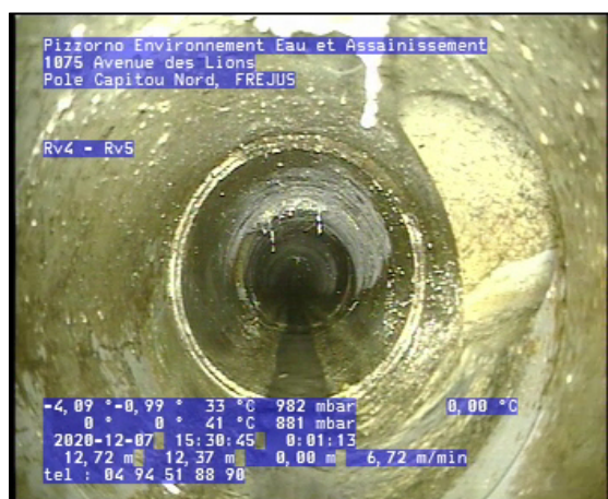
Photo: 4_4_22_B.jpg 12,72m, Culotte, raccordement ouvert à 3 h., hauteur: 125 mm, (largeur: 125 mm)
