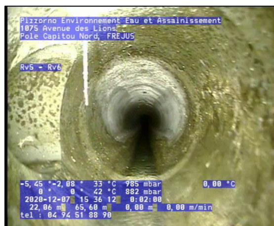
Photo: 5_5_28_A.jpg 22,03m, Culotte, raccordement ouvert à 9 h., hauteur: 125 mm, (largeur: 125 mm)
