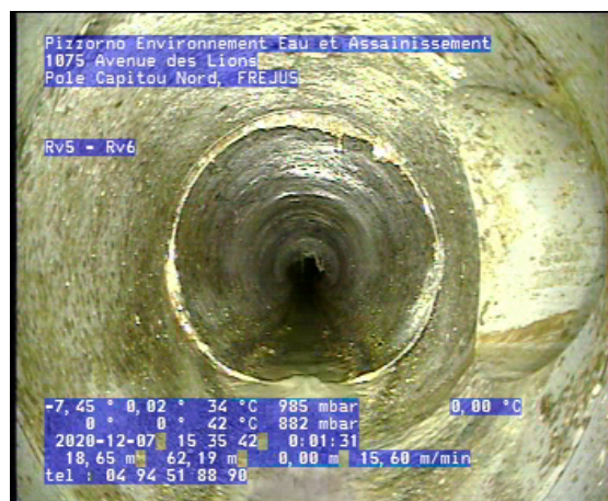
Photo: 5_5_27_A.jpg 18,65m, Culotte, raccordement ouvert à 3 h., hauteur: 125 mm, (largeur: 125 mm)
