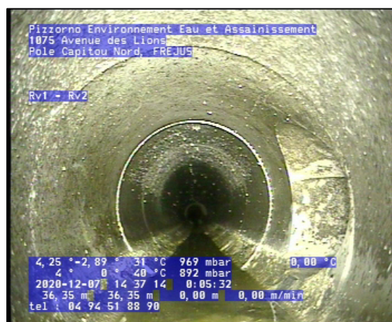
Photo: 1_1_8_A.jpg 36,35m, Culotte, raccordement ouvert à 4 h., hauteur: 125 mm, (largeur: 125 mm)
